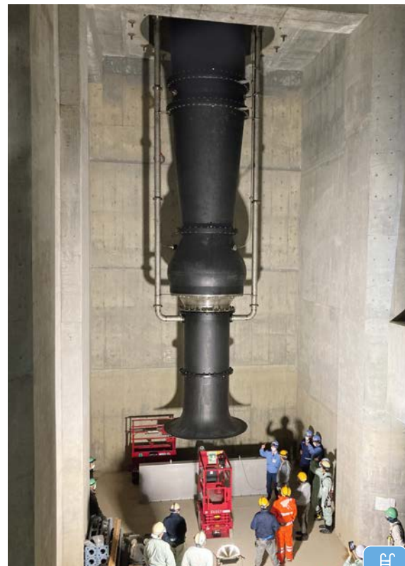
ポンプ場 / 雨水ポンプ据付
