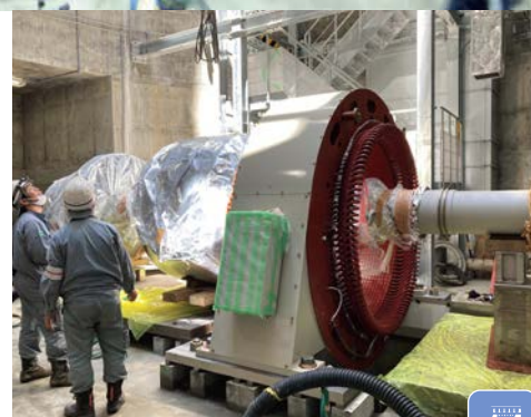
水力発電所 / 横軸回転子吊込み
