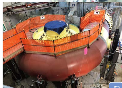
水力発電所 / ケーシング据付
