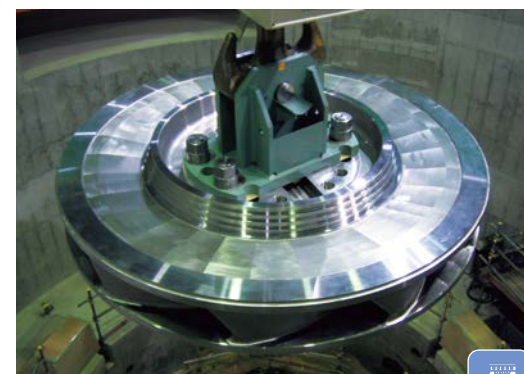
水力発電所 / ランナー吊込み
