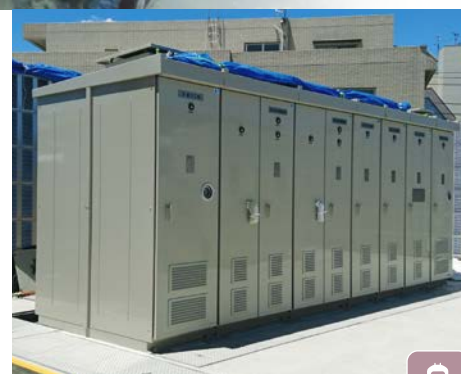
鉄道 / 高圧配電盤据付
