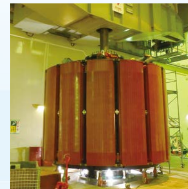
259,000kW 回転子吊り込み
