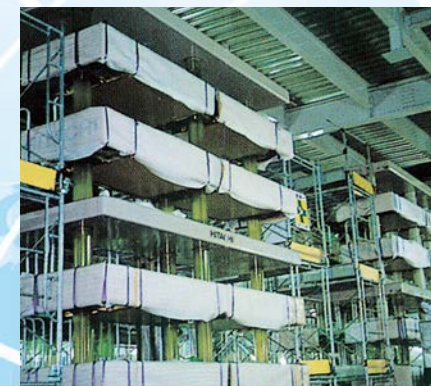
直流変換所のサイリスタバルブ据付工事
