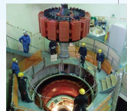
回転子吊り込み
